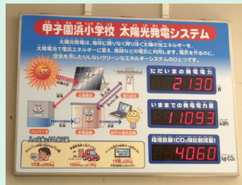
発電量のモニター
