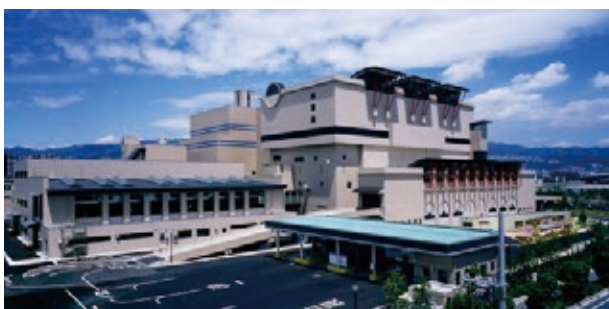
西部総合処理センター
