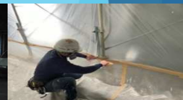
プラスチックシート養生
