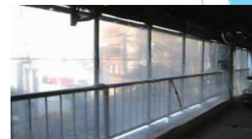
プラスチックシート養生
