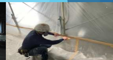
プラスチックシート養生
