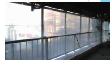
プラスチックシート養生
