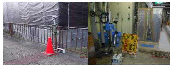
作業場所・敷地境界 セキュリティゾーン出入口
