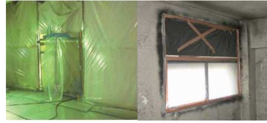
プラスチックシート養生 開口部養生
