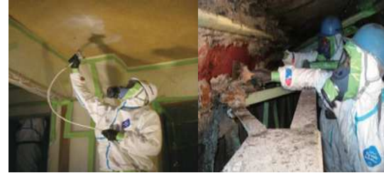
粉じん飛散抑制剤散布 アスベスト撤去
