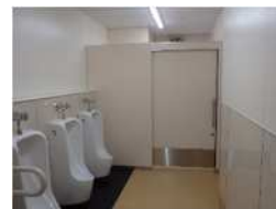
改修後：床の乾式化等 （浜脇中学校）
