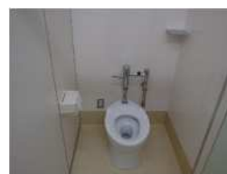
改修後：和式便器を様式便器化 （高木小学校）
