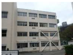
改修後（鳴尾南中学校）
