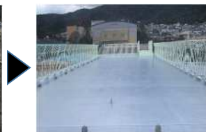
改修後（苦楽園小学校）
