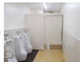
改修後：床の乾式化等 （浜脇中学校）
