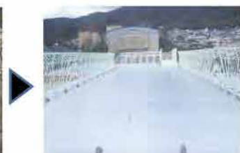
改修後（苦楽園小学校）
