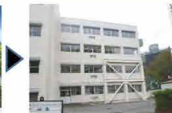
改修後（鳴尾南中学校）
