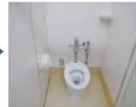
改修後：和式便器を洋式便器化 （高木小学校）
