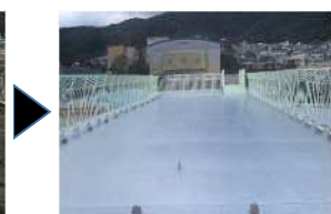
改修後（苦楽園小学校）
