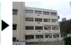
改修後（鳴尾南中学校）
