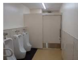
改修後：床の乾式化等 （浜脇中学校）
