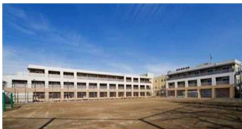
学校を改修して整備した事例
