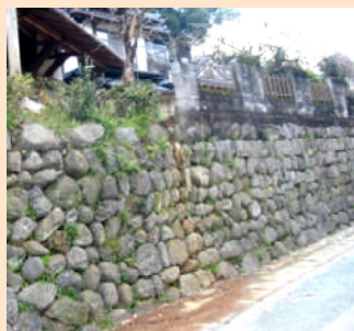
玉石積み擁壁
