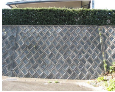
間知ブロック積み擁壁
