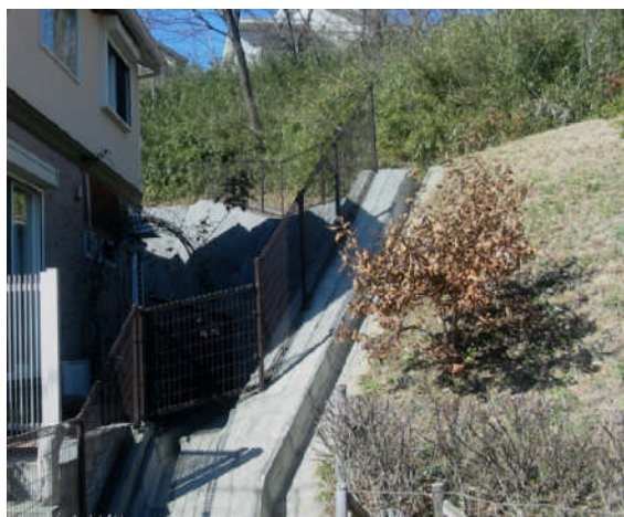
擁壁の設置によるがけの補強例
