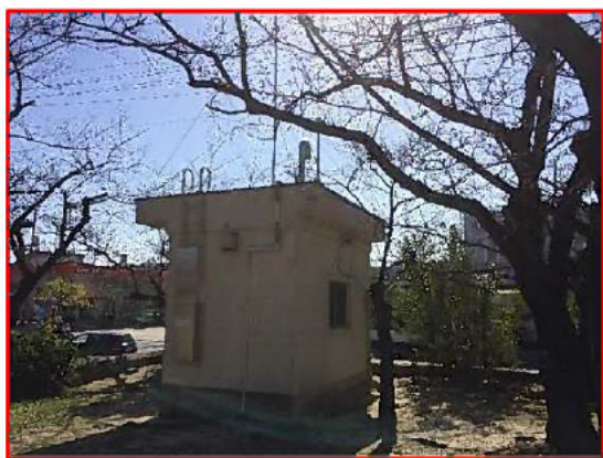
【測定局外観（北側から撮影）】
