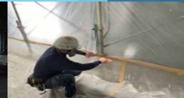
プラスチックシート養生
