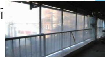
プラスチックシート養生
