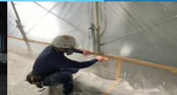
プラスチックシート養生
