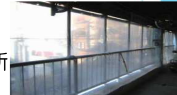
プラスチックシート養生
