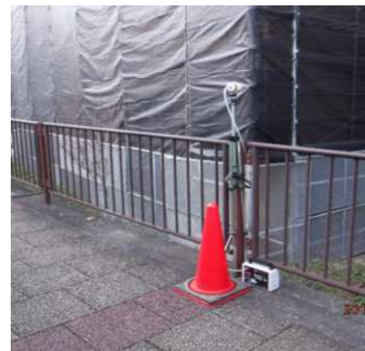
作業場所周辺測定
