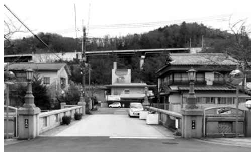
現在の乙倉橋
