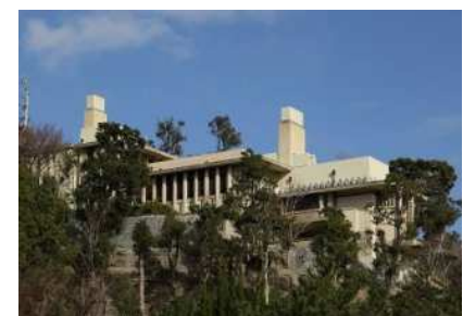
「旧山邑家住宅（淀川製鋼迎賓館）」
